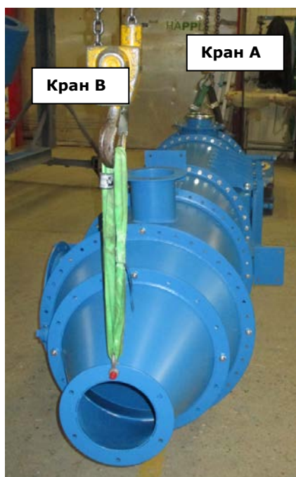
Рис. 3: Установка фильтра – продолжается как вертикальный подъем.
